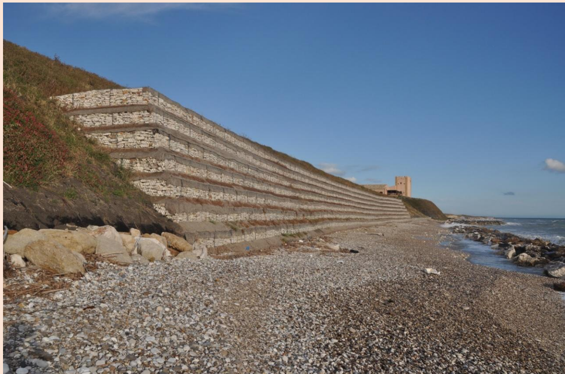
Stützmauer aus steingefüllten Gabionen. Situation: 2024 / Wall made of stone-filled gabions. Location Situation in 2024. Ralf Schmidt photo.
