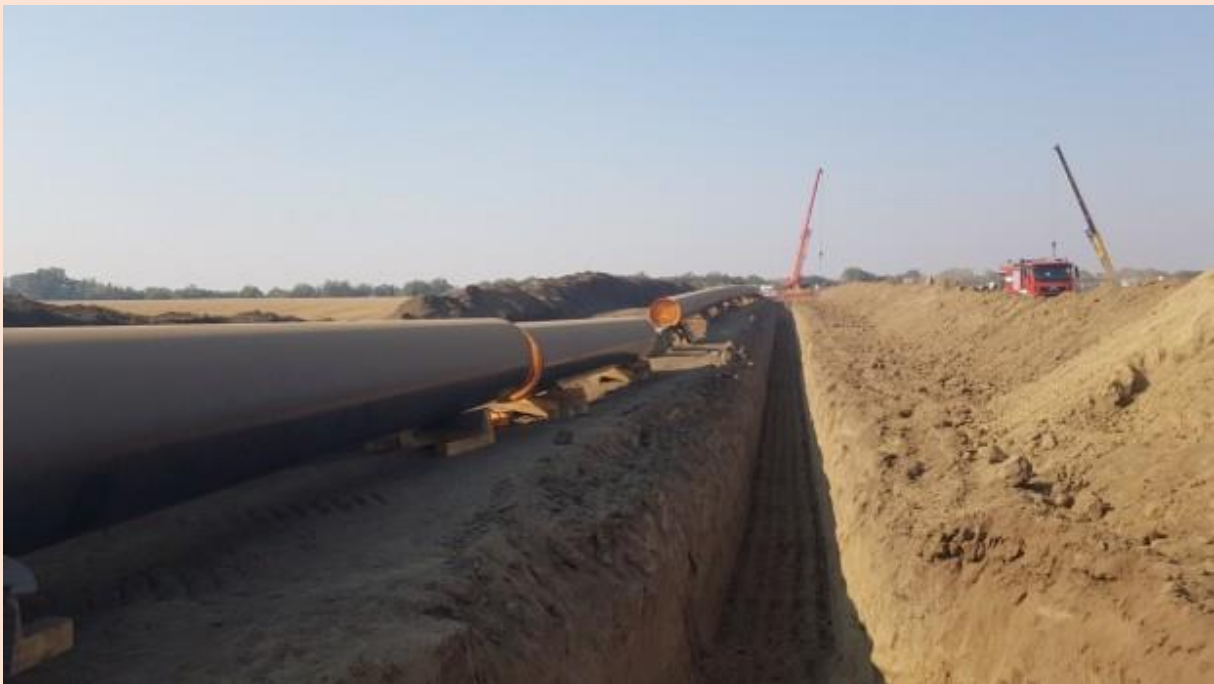
Das Fundgebiet mit der Baustelle der Pipeline 2022 / The discovery area with the pipeline construction site in 2022. Zlati Zlatev photos.
